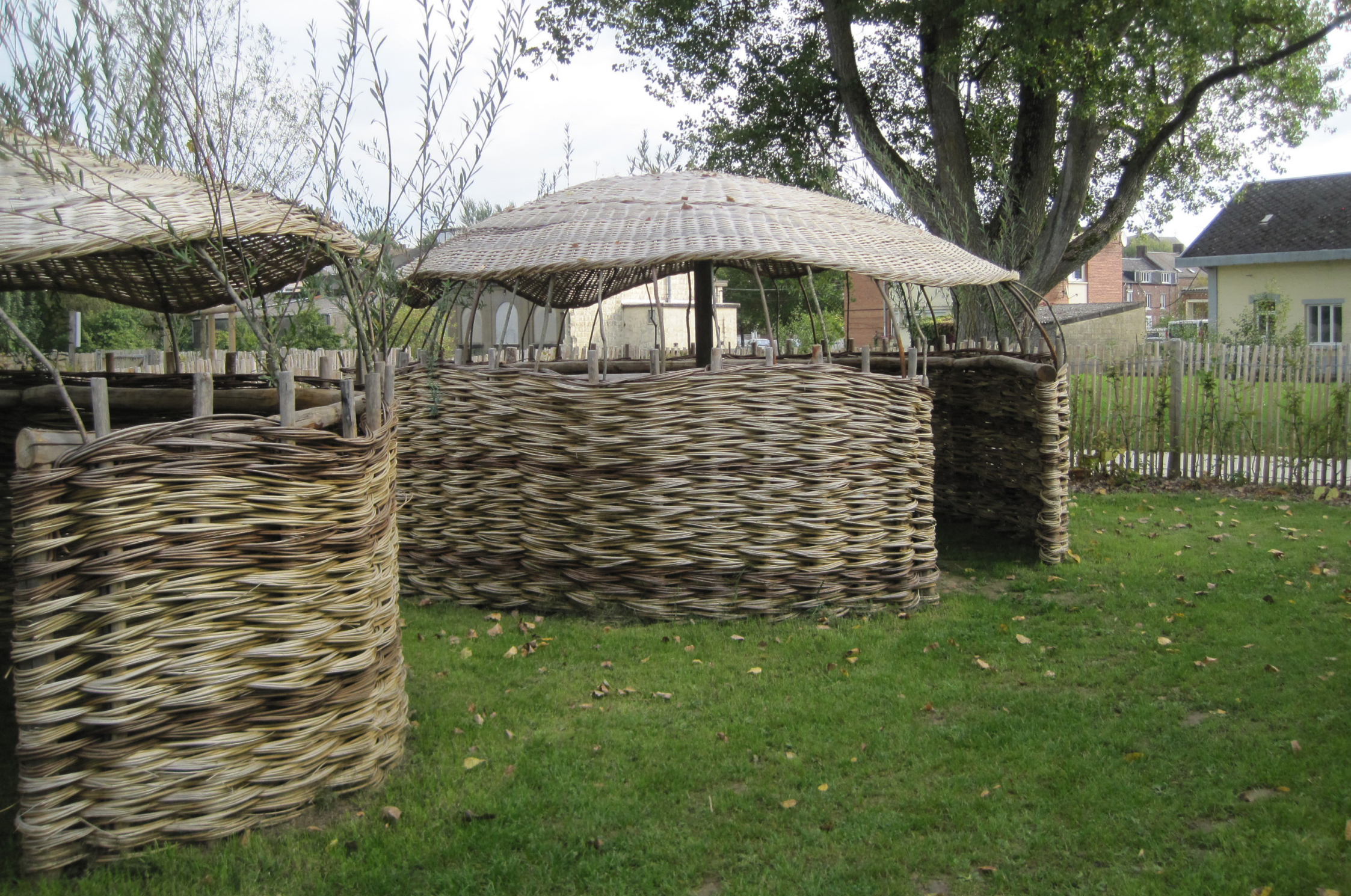
Wignehies - aménagement du parc des soigneuses - 2014 - 495.000 € H.T.
