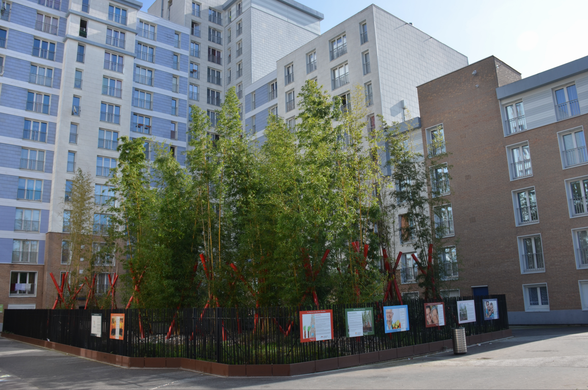
Lille - réaménagement du parvis de la résidence Trévisse - LMH - 2014 - 370.000 € H.T.
