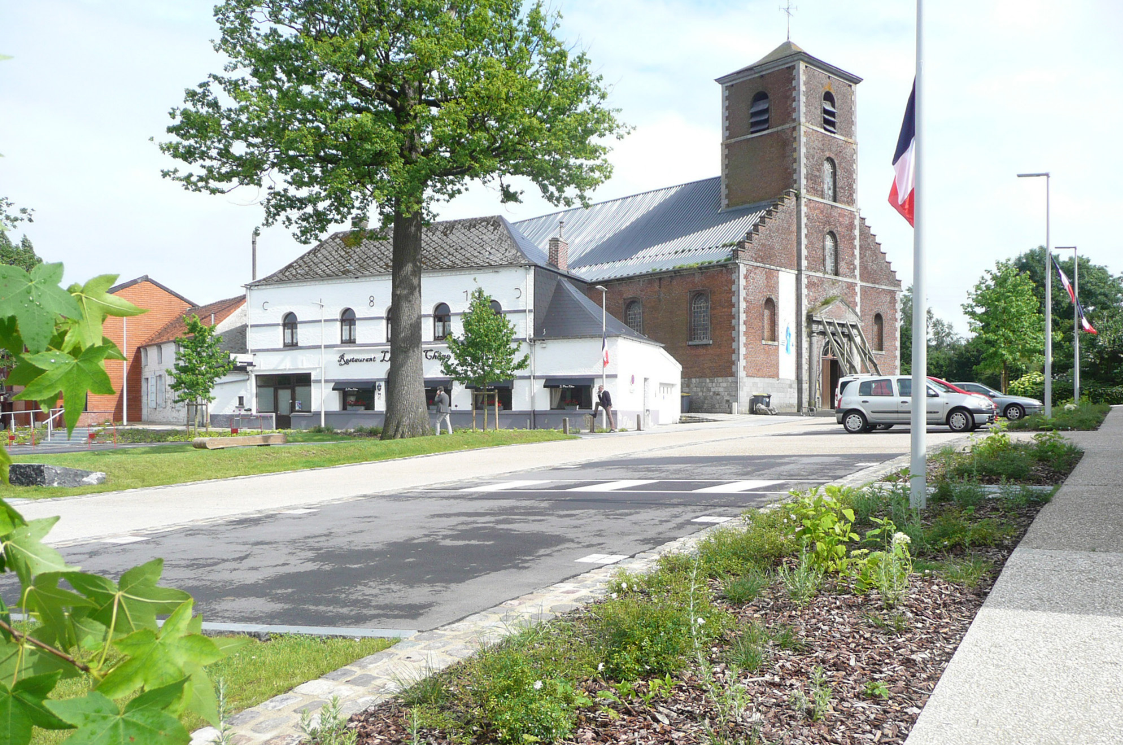
Gognies Chaussée - aménagement de la place de la République - 2016 - 615.000 € H.T.
