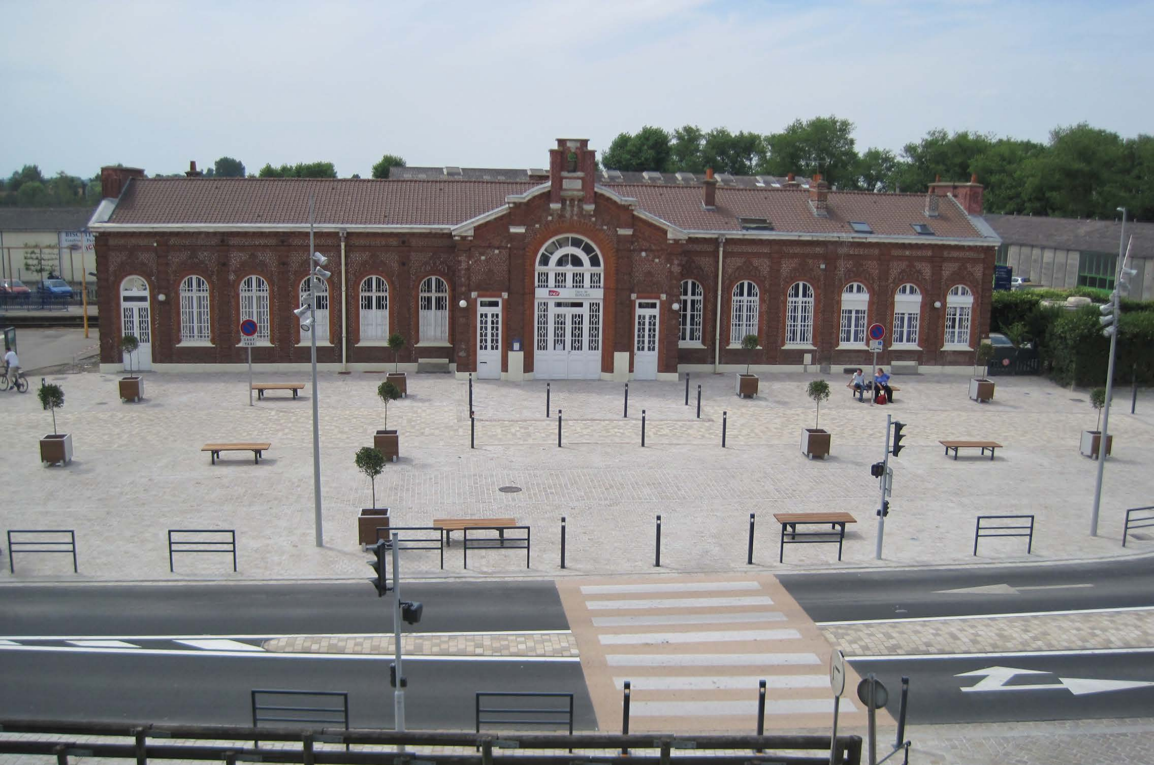
Bergues - aménagement du pôle d'échange - 2010 - 1.750.000 € H.T.
