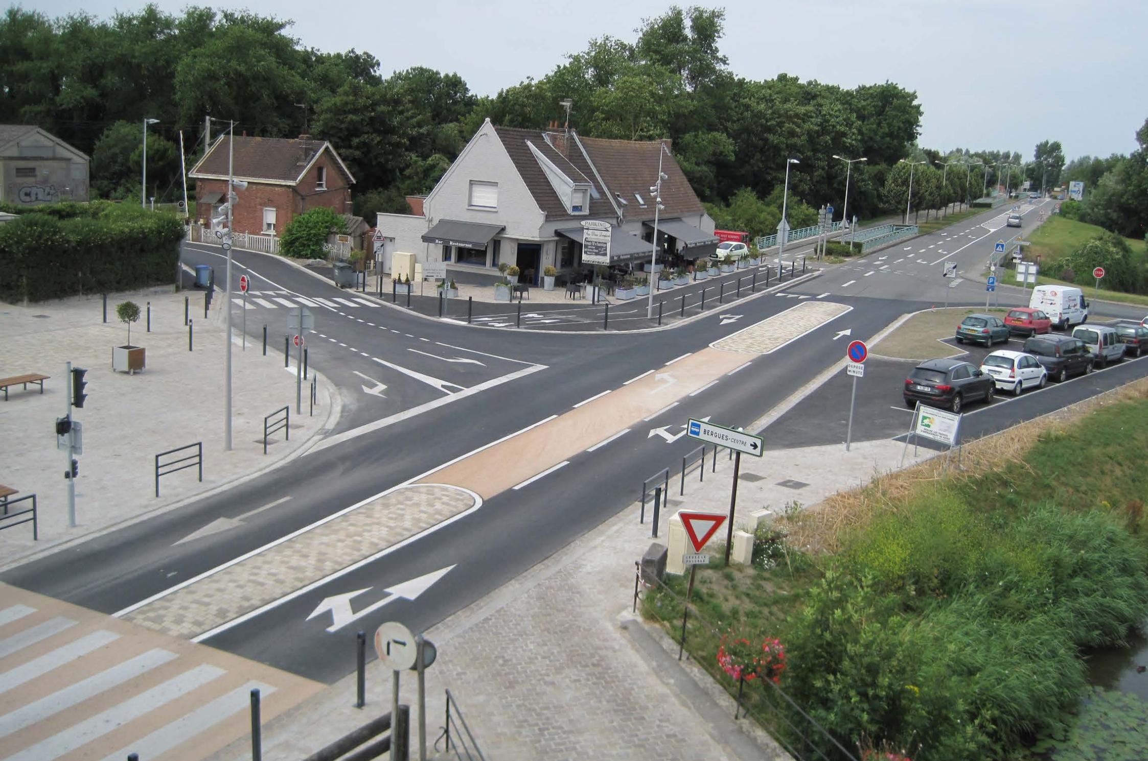
Bergues - aménagement du pôle d'échange - 2010 - 1.750.000 € H.T.
