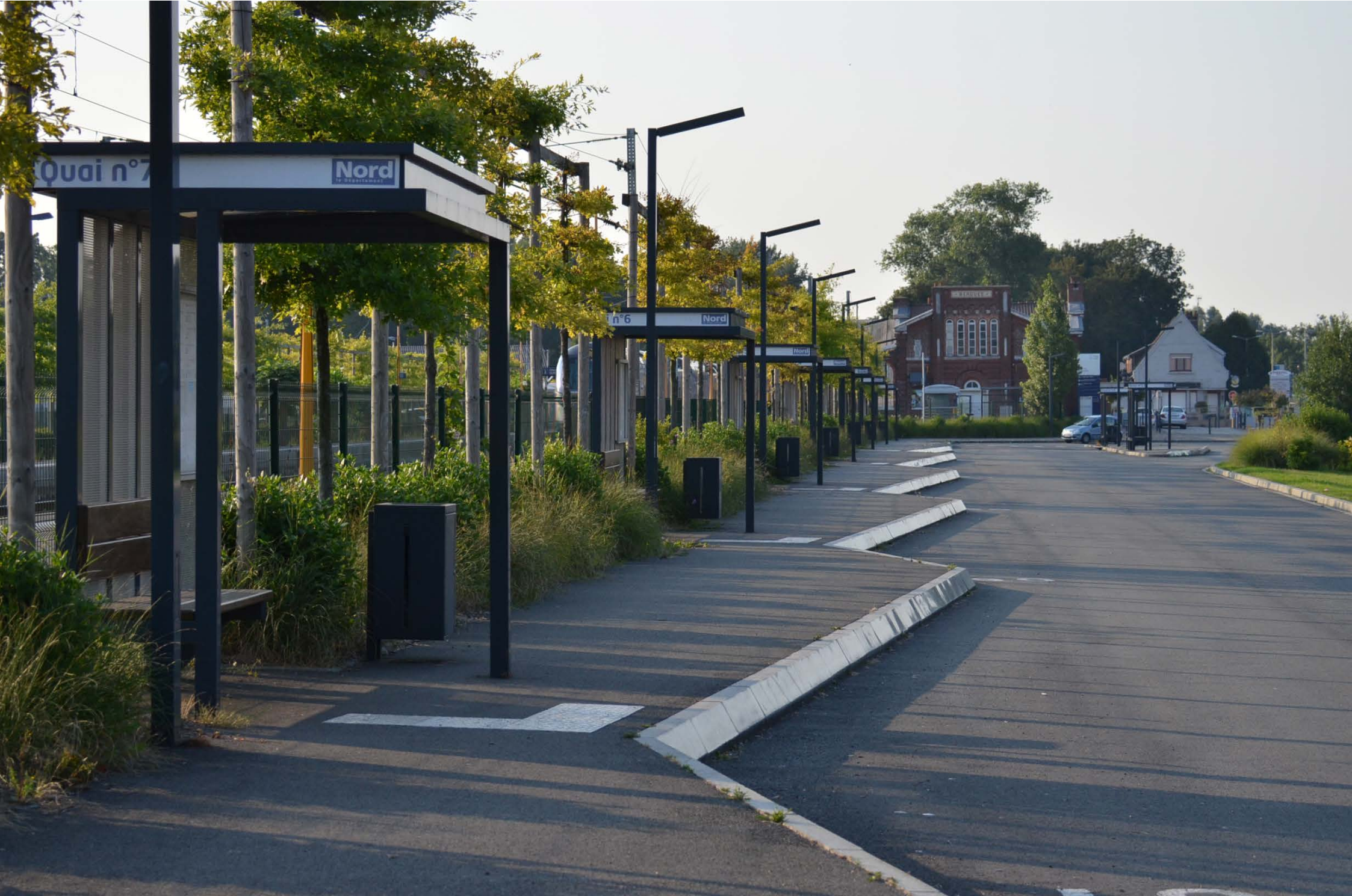
Bergues - aménagement du pôle d'échange - 2010 - 1.750.000 € H.T.
