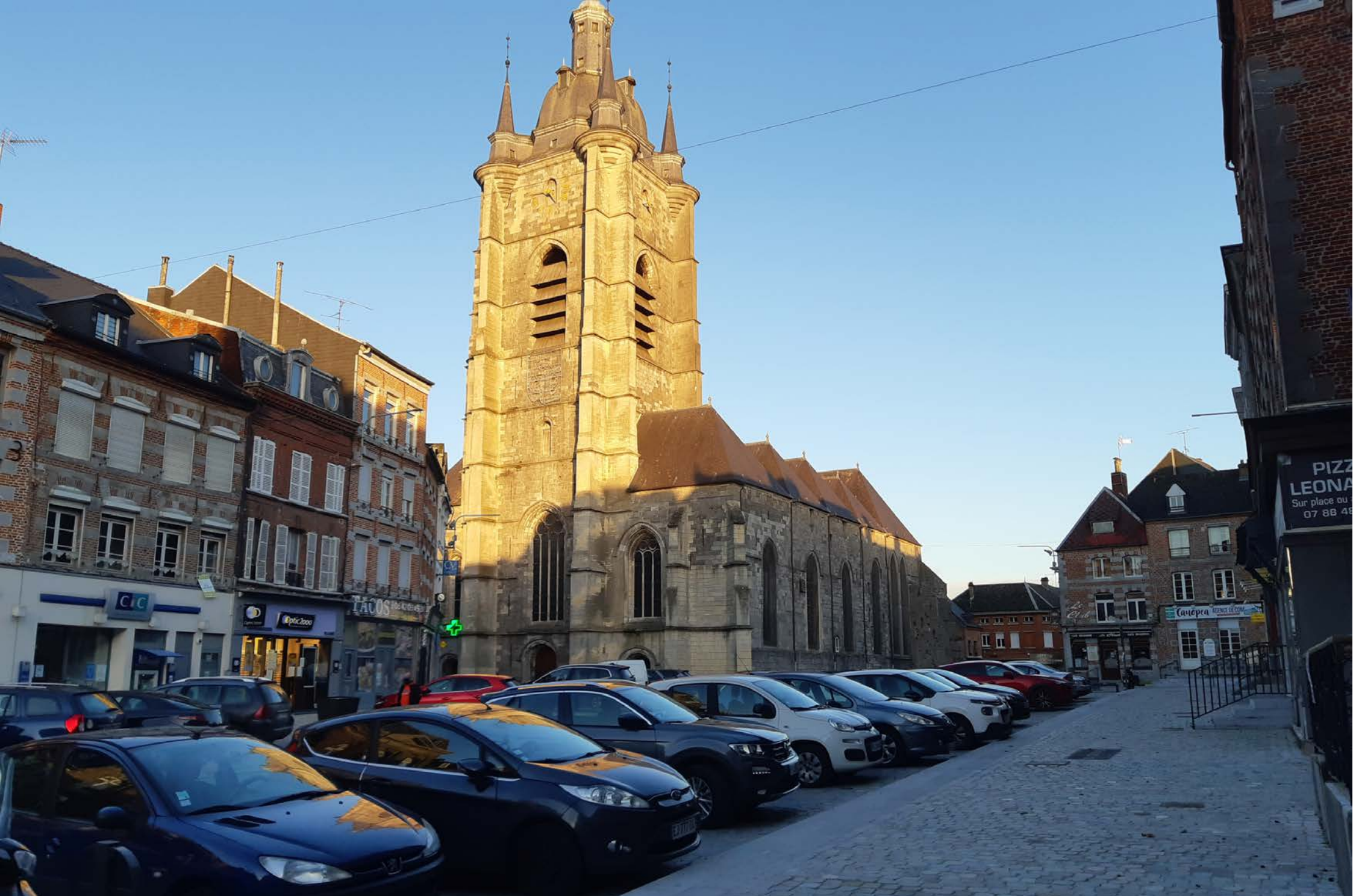
Avesnes-sur-Helpe - place du Général Leclerc - 2021 - 1.160.000 € H.T.
